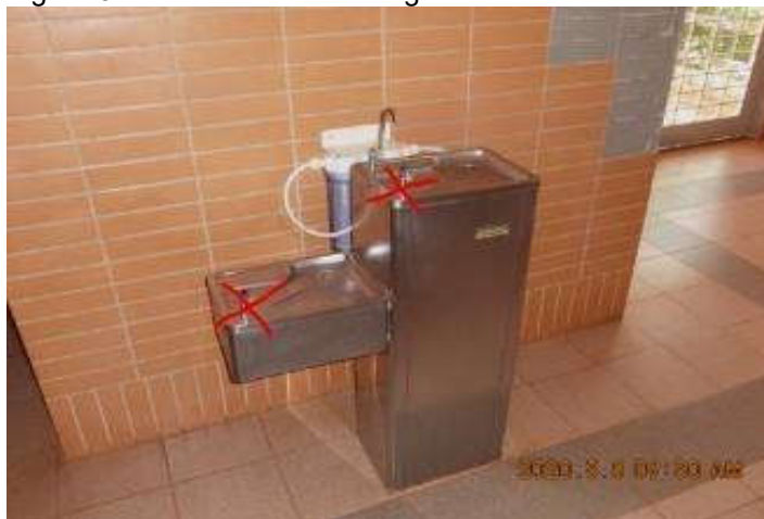
Figura 6 - Inutilizar saídas de água do bebedouro
